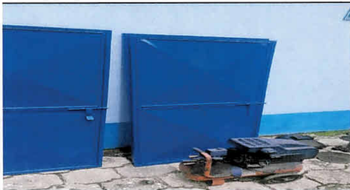
Foto 3: SUSTITUCION DE PUERTAS DE METAL DE BAÑOS
