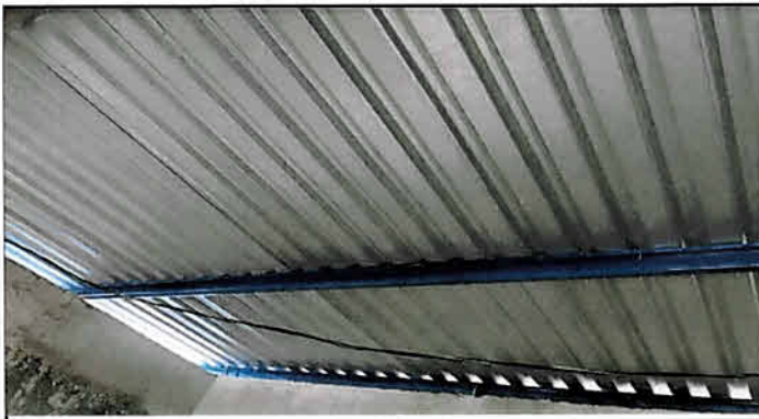
Foto 1: sustitución de lamina por lamina calibre 26
