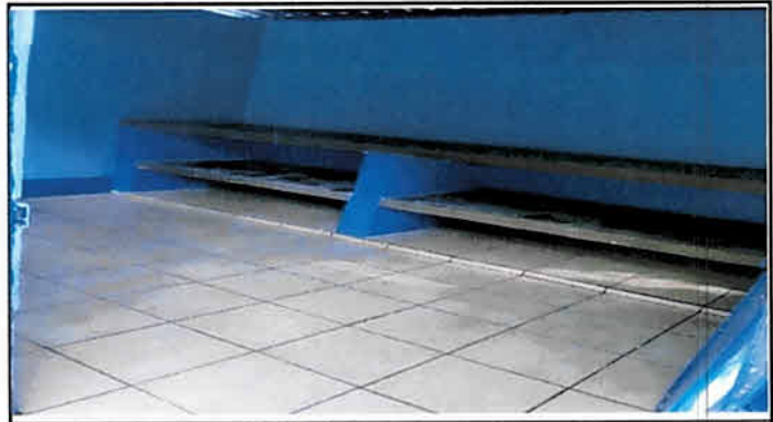
Foto 2: Sustitución de piso cerámico
